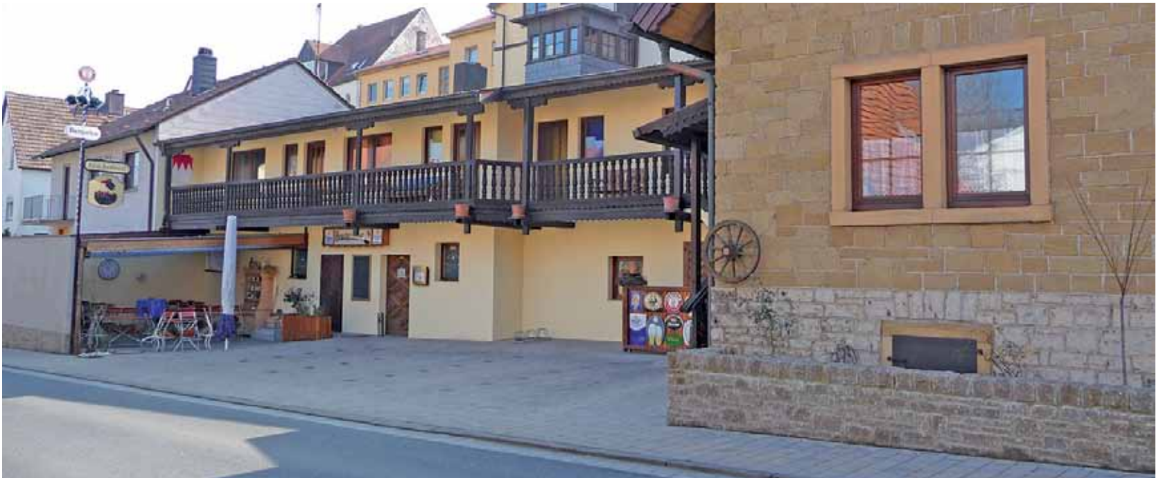
Hof und Gehweg bilden ein sauberes und einheitliches Erscheinungsbild
