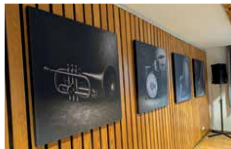
Gute Akustik im Proberaum mit den neuen Akustikpaneelen.
